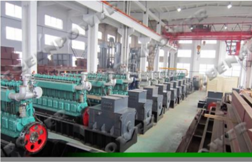
Foto van een 3MW plant in Indonesië: de low speed syngas gensets.
